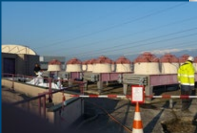
▲ Les anciens refroidisseurs ont été démontés avant le montage de la nouvelle installation...
