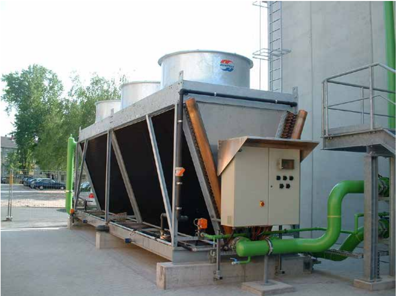
Refroidisseur sec hybride HTK 2.4/9.0 pour le refroidissement d'un banc d'essais, puissance de refroidissement de 1900 kW à des températures de fluide de 35/28 °C
